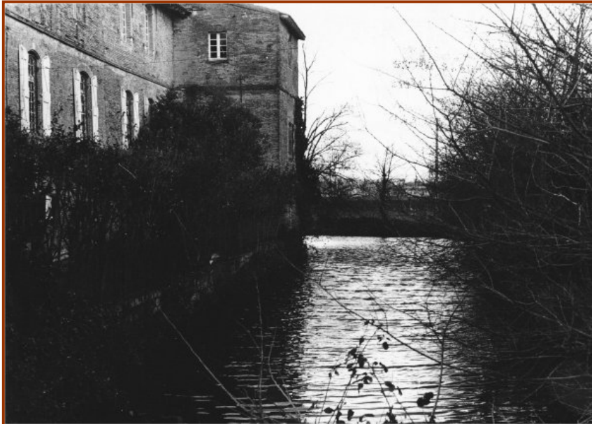
Façade nord avec le fossé et la tourelle ouest.
